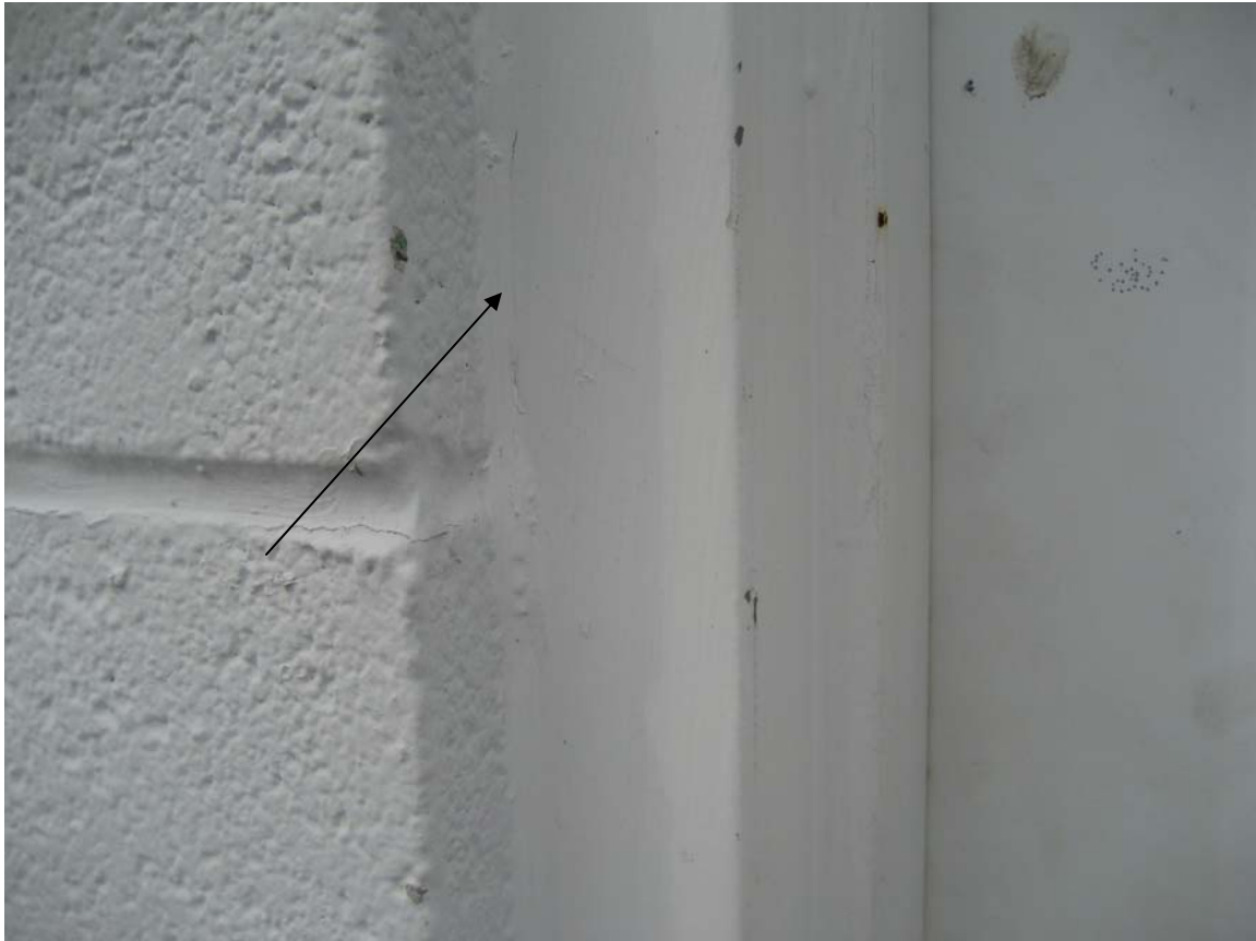
HA #7 – Non asbestos containing white exterior caulk
